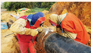
燃气管道焊接
