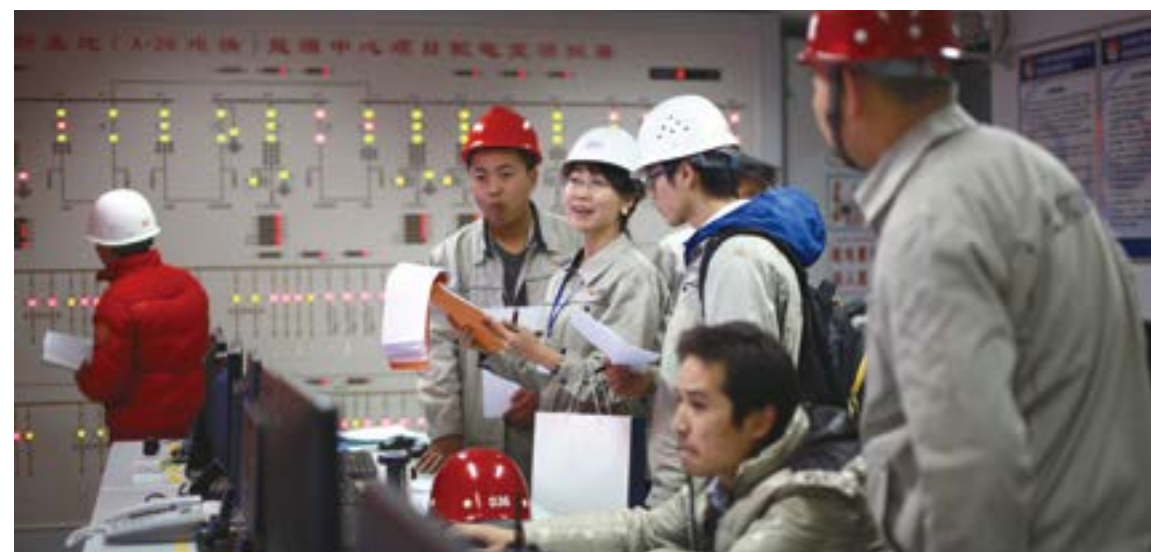
中石油科技創新基地能源中心項目
